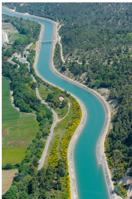
Photos du canal EDF
