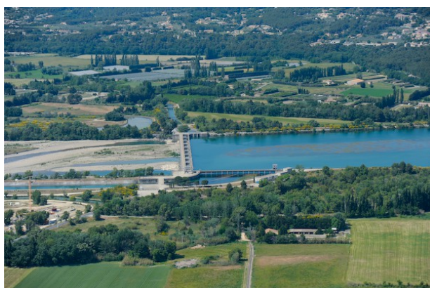
Barrage de Mallemort
